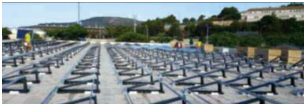
Instalación de cubiertas de impermeabilización fotovoltaicas realizada por Norteña.
