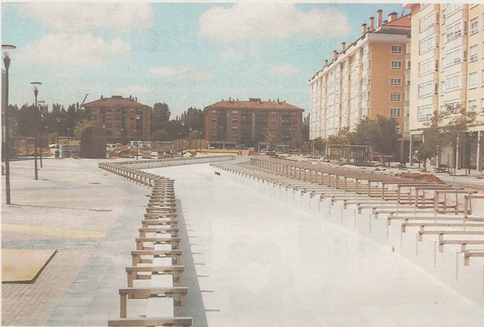
PARQUE FÉLIX. LOS TRABAJOS DE IMPERMEABILIZACIÓN DEL PARQUE HAN SIDO REALIZADOS POR NORTEÑA. / D8
